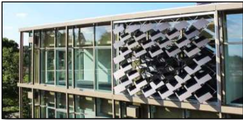
صورة (3) ألواح الطاقة الشمسية المتحركة ذاتياً (20)
