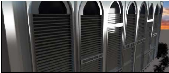
صورة (12) الشاشة التفاعلية على الواجهة الشرقية (المصدر) صورة (13) لكاسرات المعدنية بأعلى الزجاج (المصدر الباحث) (3/2/2/4) المرحلة الثانية للمشروع (تقييم الحالة بالتصميم المقترح): من خلال اختبارات المحاكاة
