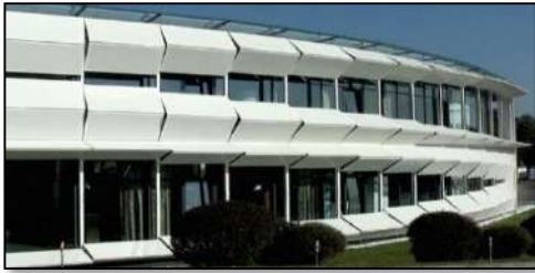
صورة (2) الألواح المتحركة بمبنى كيفر بالانمسا (19)
