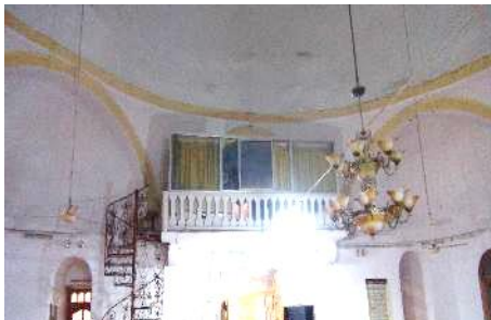
الصورة (18): الواجهة الشمالية للحرم.
